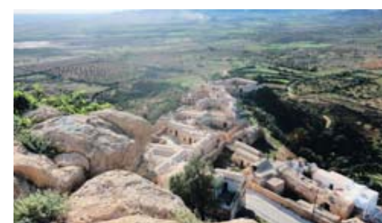
TAKROUNA Un village berbère en cours de réhabilitation.
